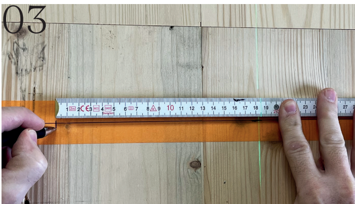
Vom Mittelpunkt auf beiden Seiten 185,5 mm vermessen, damit ein Abstand von 371 mm für die ersten beiden Bohrlocher entsteht.
