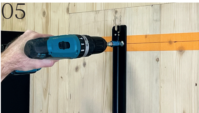
Beide Schienen mit dem ersten Schrauben fixieren.
