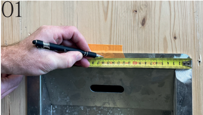
Mittelpunkt der Unterputzdose ausmessen
