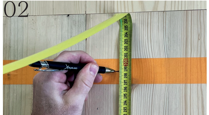
Mittels Laser oder Wasserwaage über dem Mittelpunkt die Höhe von 1988 mm* (über OKFF) markieren und einen waagrechten Strich ziehen.
