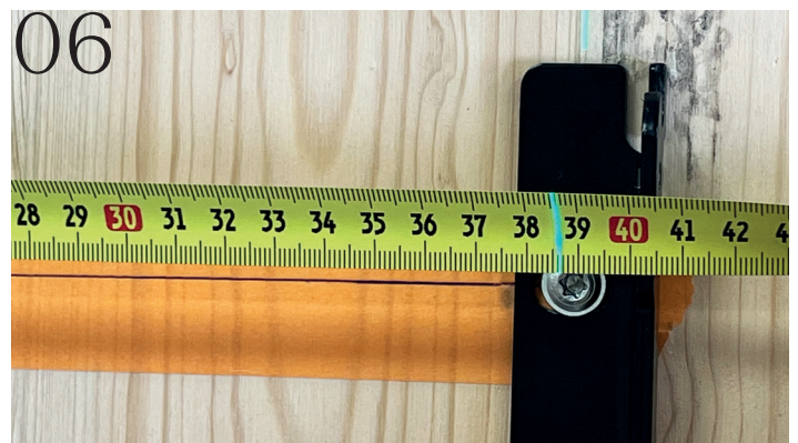
Abstand kontrollieren! Außenkante zu Außenkante: 405 mm
