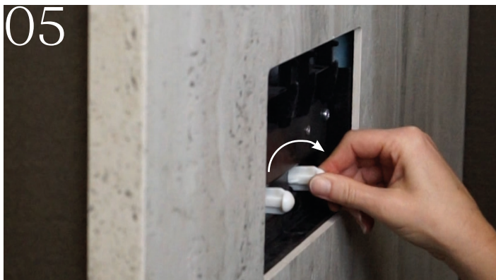
Drückerstäbe einsetzen, fixieren und Funktion prüfen
