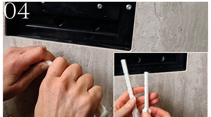
Bei Bedarf Länge der Drückerstäbe kürzen
