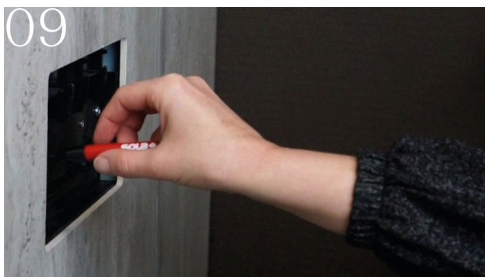
Wird Zugang zum Spülkasten benötigt, kann die Grundplatte für Wartungsarbeiten demontiert werden.
